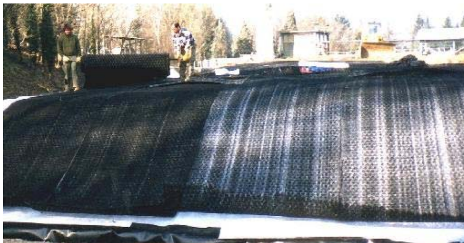
Esempio di posa di una geostuoia rinforzata per la stabilizzazione di scarpate a basso angolo di attrito. Nella foto: discarica di rifiuti industriali bonificata.
